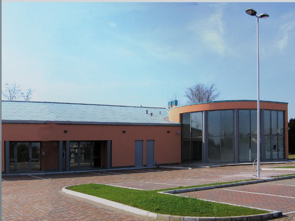
Parziale veduta della nuova sede dell'Ordine
