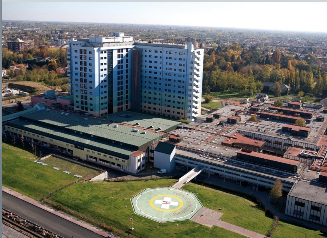
Veduta aerea dell'Ospedale Civile di Castelfranco
